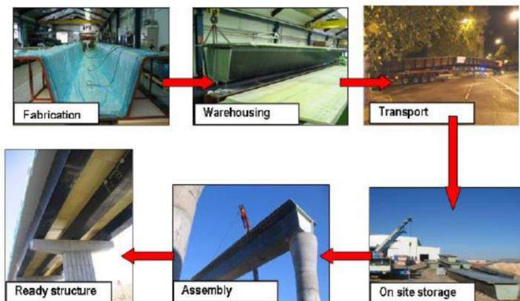
Ilustración 66: Fases principales de la construcción de un puente o pasarela en FRP (Primi & Paulotto, 2011)
