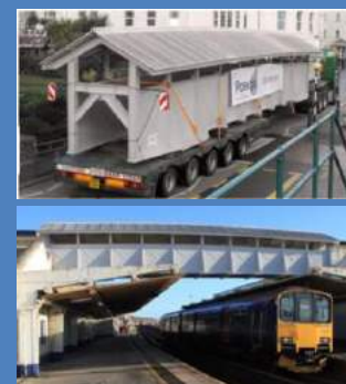
Ilustración 5: Ejemplificación Prefabricación. Puente de estación de tren de Dawlish (Kendall, 2014)
