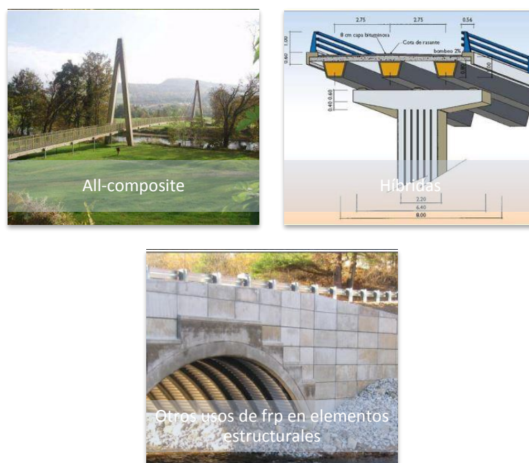
Ilustración 40: Arriba Izqda.: Primera pasarela all-composite (ACCS) en Aberfeldy (Escocia). Arriba drcha. : Esquema estructural del puente de la autovía del Cantábrico, primer puente carretero en FRP de Europa. (Acciona) Abajo, empleo de placa-arco de CFRP en el Royal Bridge (Auburn, Maine. Empresa AIT Bridges)
