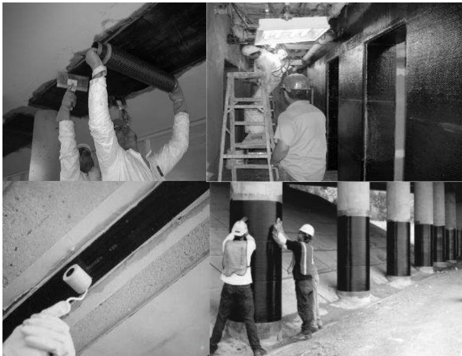
Ilustración 39: Distintos usos de FRP en refuerzo en forjados, muros, vigas y pilas
