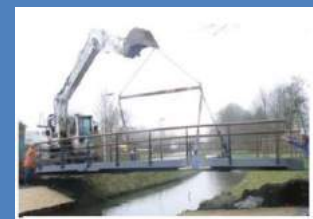
Ilustración 6: Pasarela FRP siendo levantada con una retro (Kendall, 2014)
