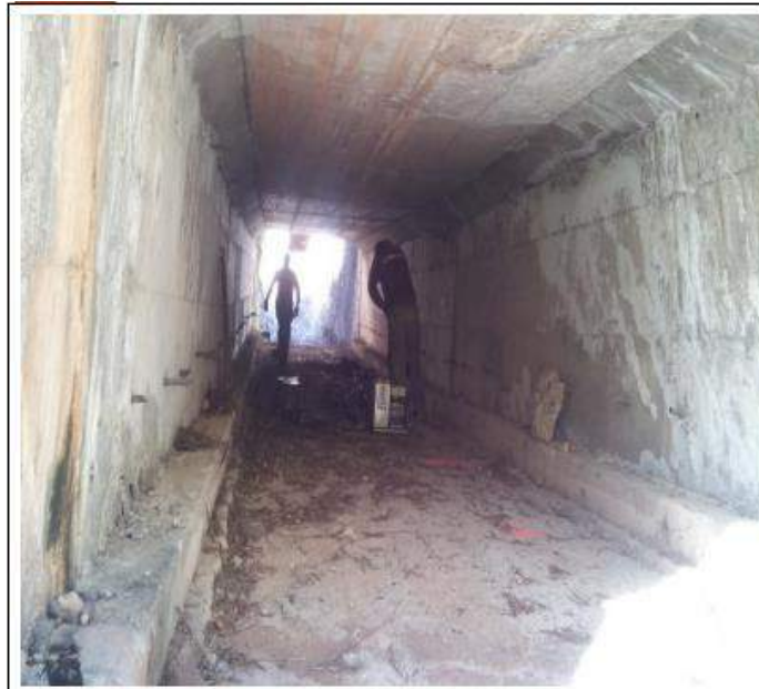
Interior del cajón de drenaje intervenido URETEK
