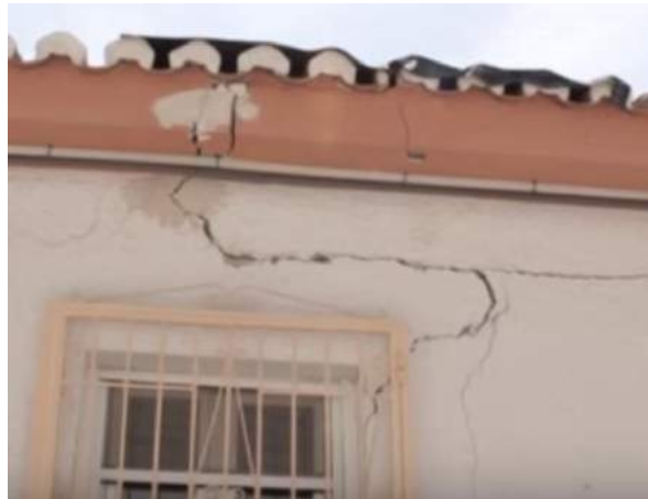
Ejemplo de grieta debida a asiento diferencial GEOSEC
