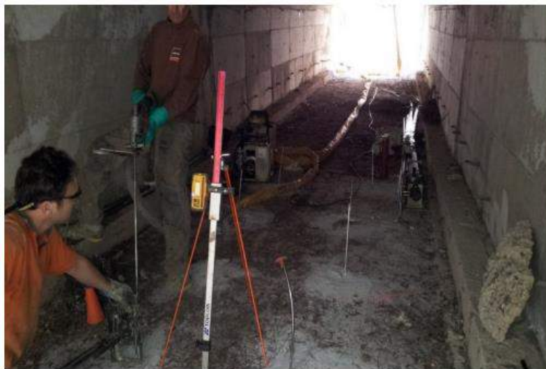
Trabajo y equipo durante la intervención URETEK
