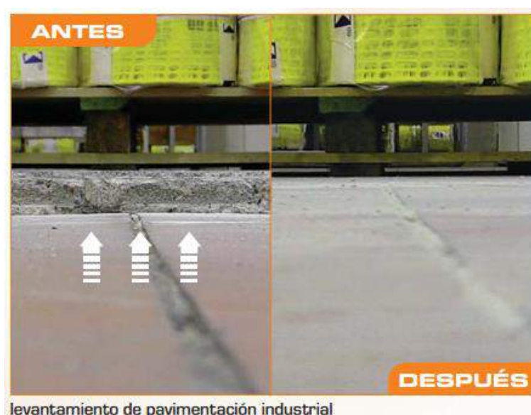
Imagen comparativa de una ejecución FLOOR LIFT URETEK
