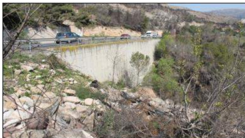
Exterior del cajón de drenaje intervenido URETEK
