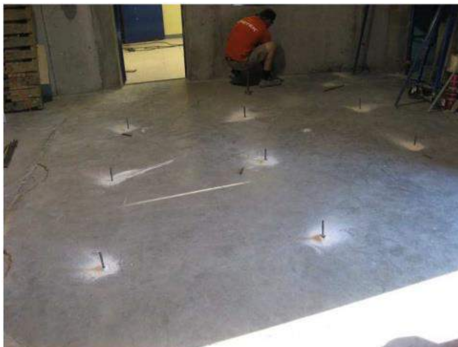
Vainas de inyección en la solera URETEK
