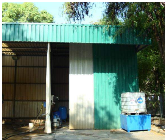
Figura 1.6: Nave de estructura metálica zona de lavado
