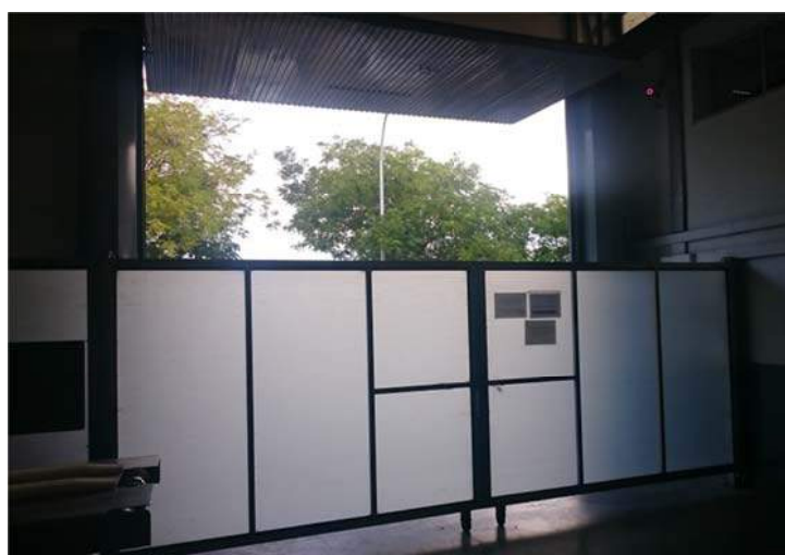
Figura 6-3. Puertas translúcidas instaladas en zona 1.
