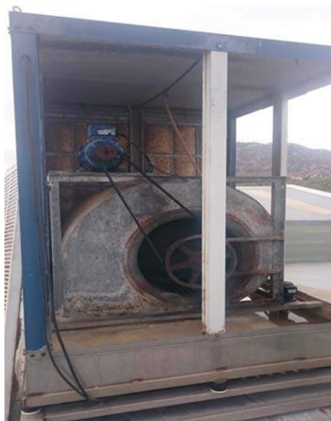
Figura 8-2. Conjunto motor-turbina equipo refrigeración.
