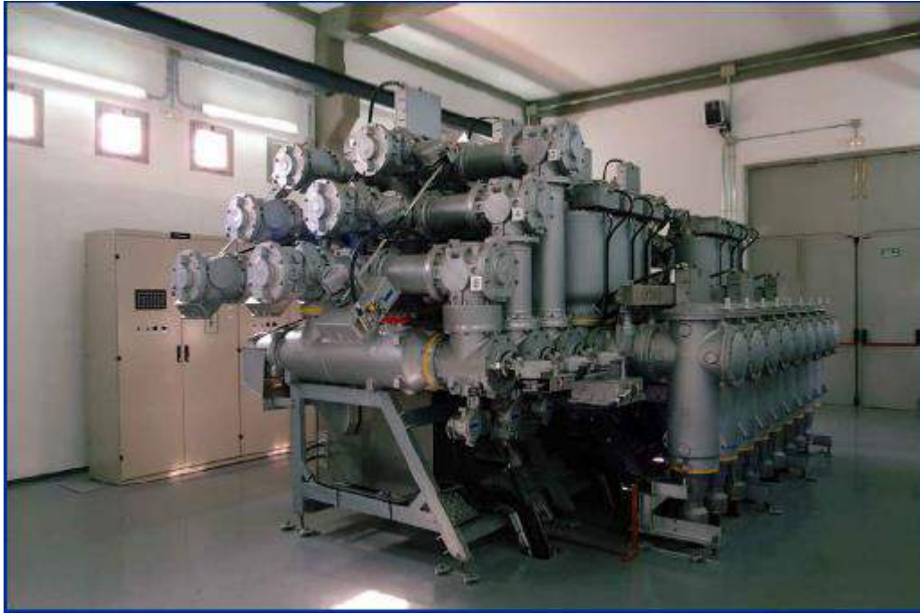
Ilustración 2-3: Subestación de interior tipo GIS.
