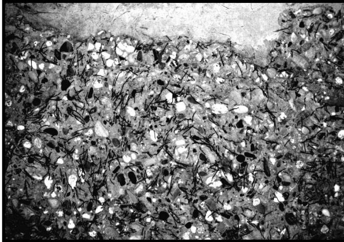
Fig. 8.7 Losa de hormigón con cóctel de fibras después del ensayo frente al fuego
