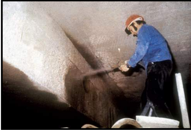
Fig. 5.4 Reparación de elementos con gunita (hormigón proyectado)
