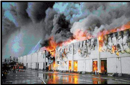
Fig. 5.13 Los paneles sándwich ligeros se derrumbaron en este incendio propagándose a los edificios adyacentes
