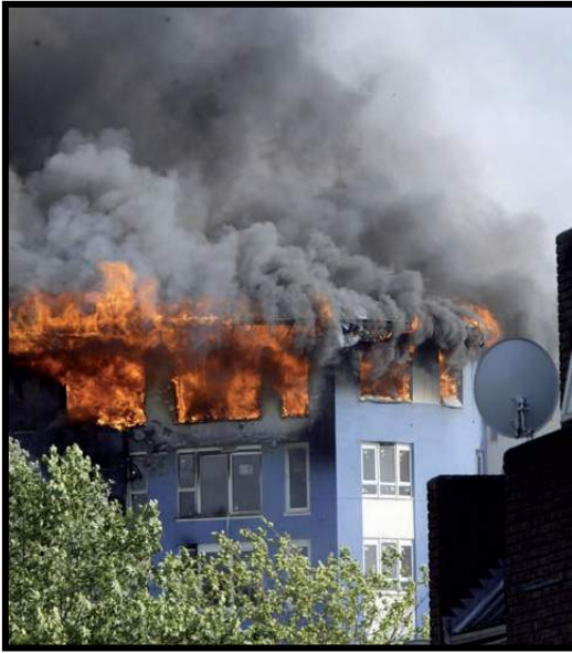
Fig. 5.12 El incendio de Colindale de los edificios residenciales con estructura de madera en construcción duró 5 horas y precisó de 100 bomberos y 20 bombas para controlarlo.
