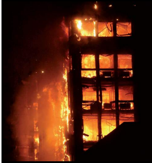
Fig. 5.8 La fachada por encima de la planta técnica del piso 16 quedó completamente destruida
