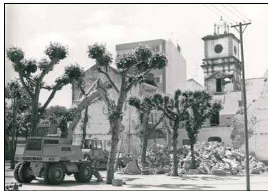
Figura 1.8.: Demolición del antiguo ayuntamiento
