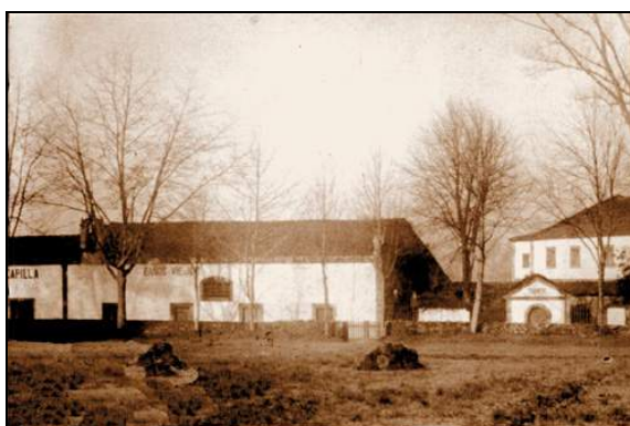
Figura 1.6.: Balneario Baños Vellos
