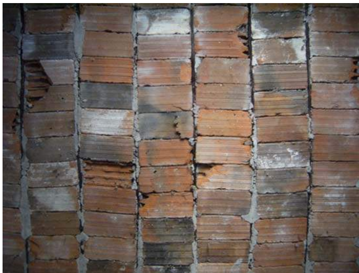
Figura 2.4.: Estructura de ladrillo con hierro enfoscado
