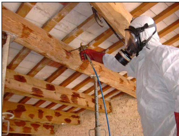
Figura 1.7.: Inyección de soluciones anti-xilófagos
