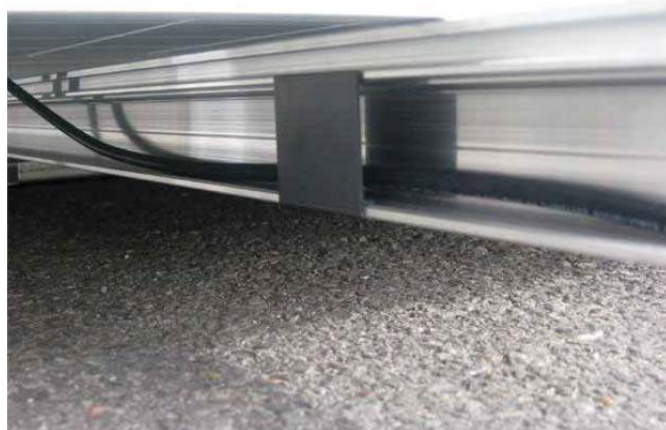
Fig. 49 Raíles para el tendido del cableado
