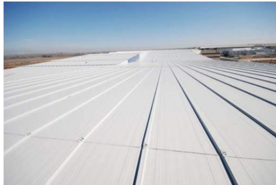
Fig. 27 Cubierta de paneles sándwich
