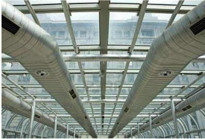
Ilustración 82. Rejillas difusión de aire en la zona industrial
