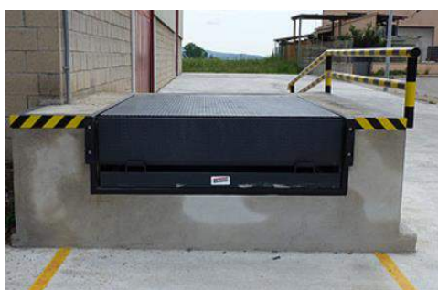
Figura 270: Rampa hidráulica (izda) y muelle de carga (dcha)
