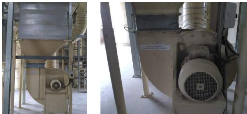
Figura 74: Filtro de mangas (izda) y ventilador centrífugo (dcha). Heineken Sevilla.
