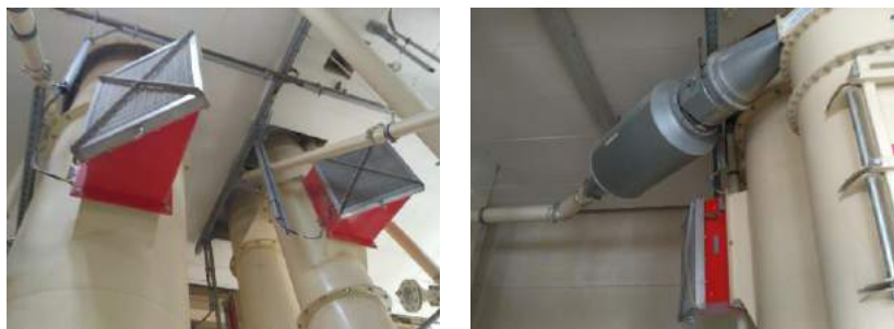
Figura 75: Paneles de venteo con apagallamas (dcha) y válvula de aislamiento (izda). Heineken Sevilla.
