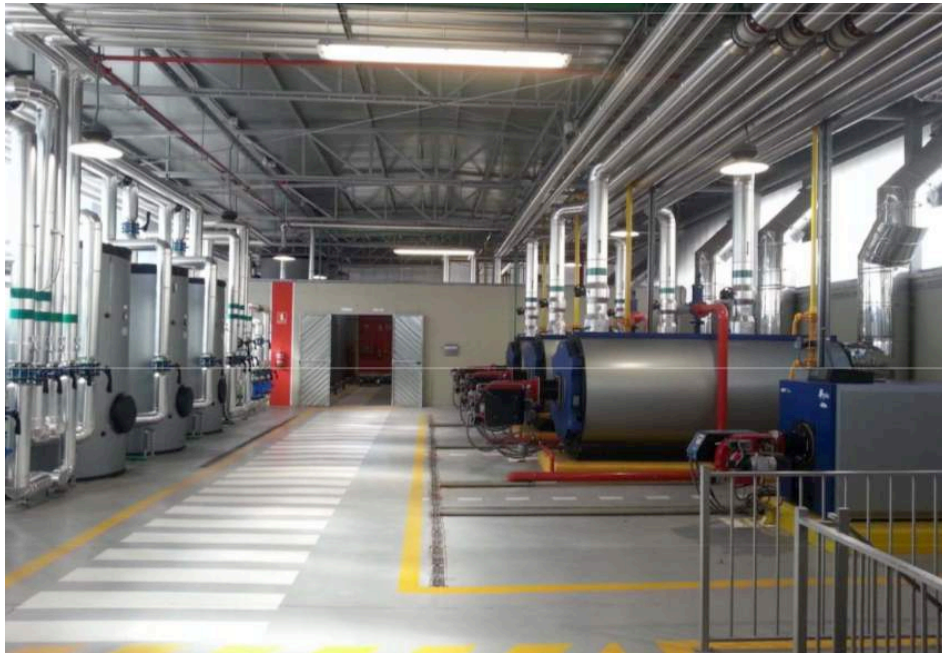
Figura 1.17. Sistema auxiliar de producción de ACS.
