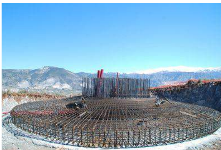
Ilustración 15. Ferrallado de la estructura inferior y superior
