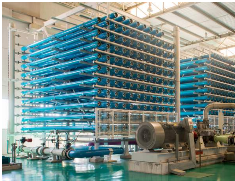
Ilustración 16. Bastidores de Osmosis Inversa
