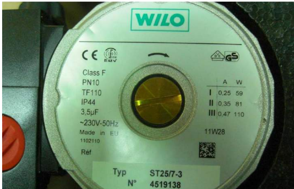
Figura 8.- Detalle de la bomba del grupo hidráulico
