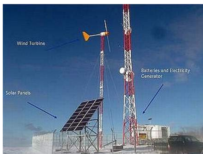
Fig.4.2. Antena de telefonía alimentada por paneles fotovoltaicos
