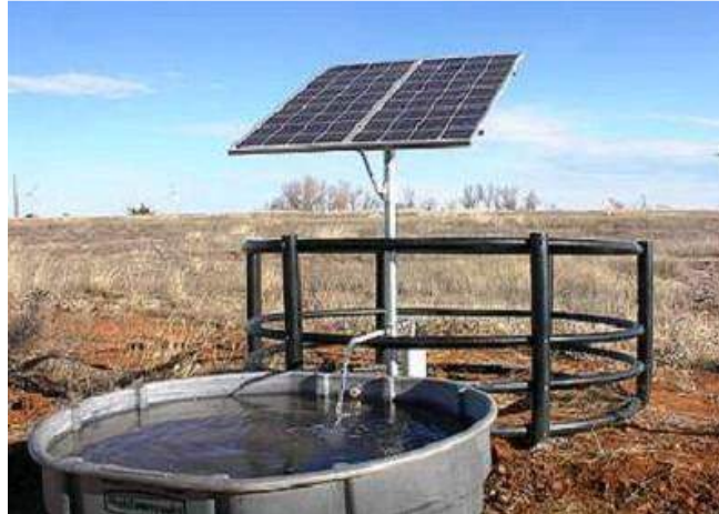
Fig.4.3. Sistema de bombeo mediante paneles fotovoltaicos
