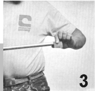
Fig. 2.13. Limpieza exterior del tubo e interior de la conexión
