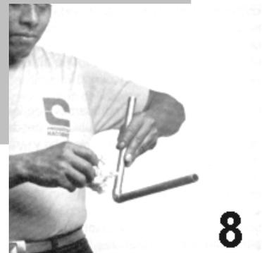
Fig. 2.18. Limpieza de la unión
