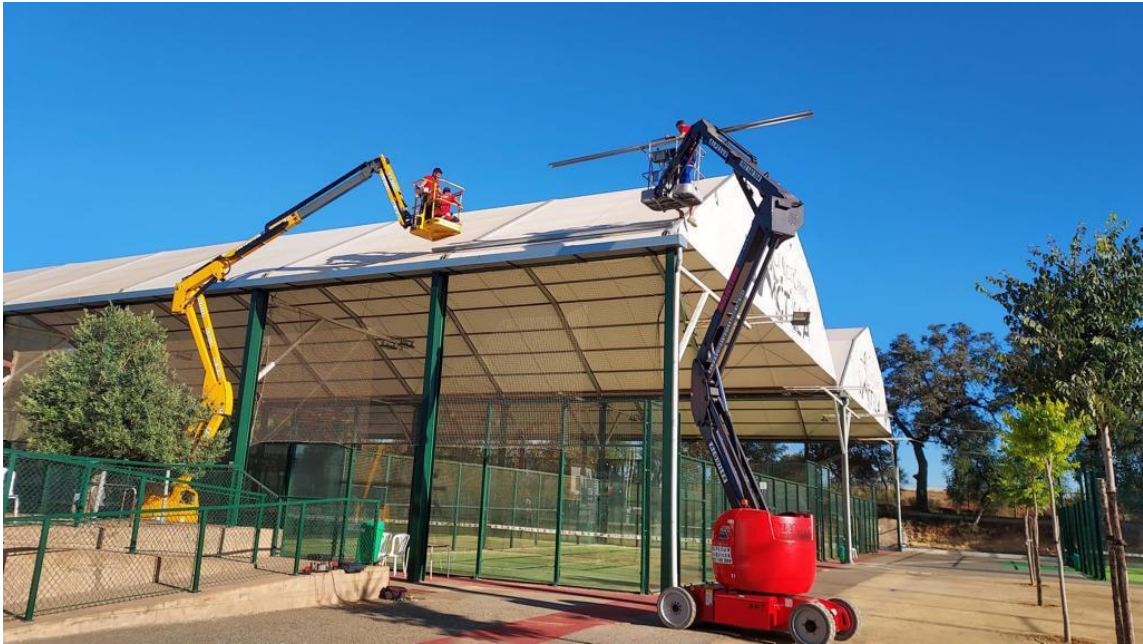
Ilustración 16. Proceso de instalación de paneles fotovoltaicos 1.
