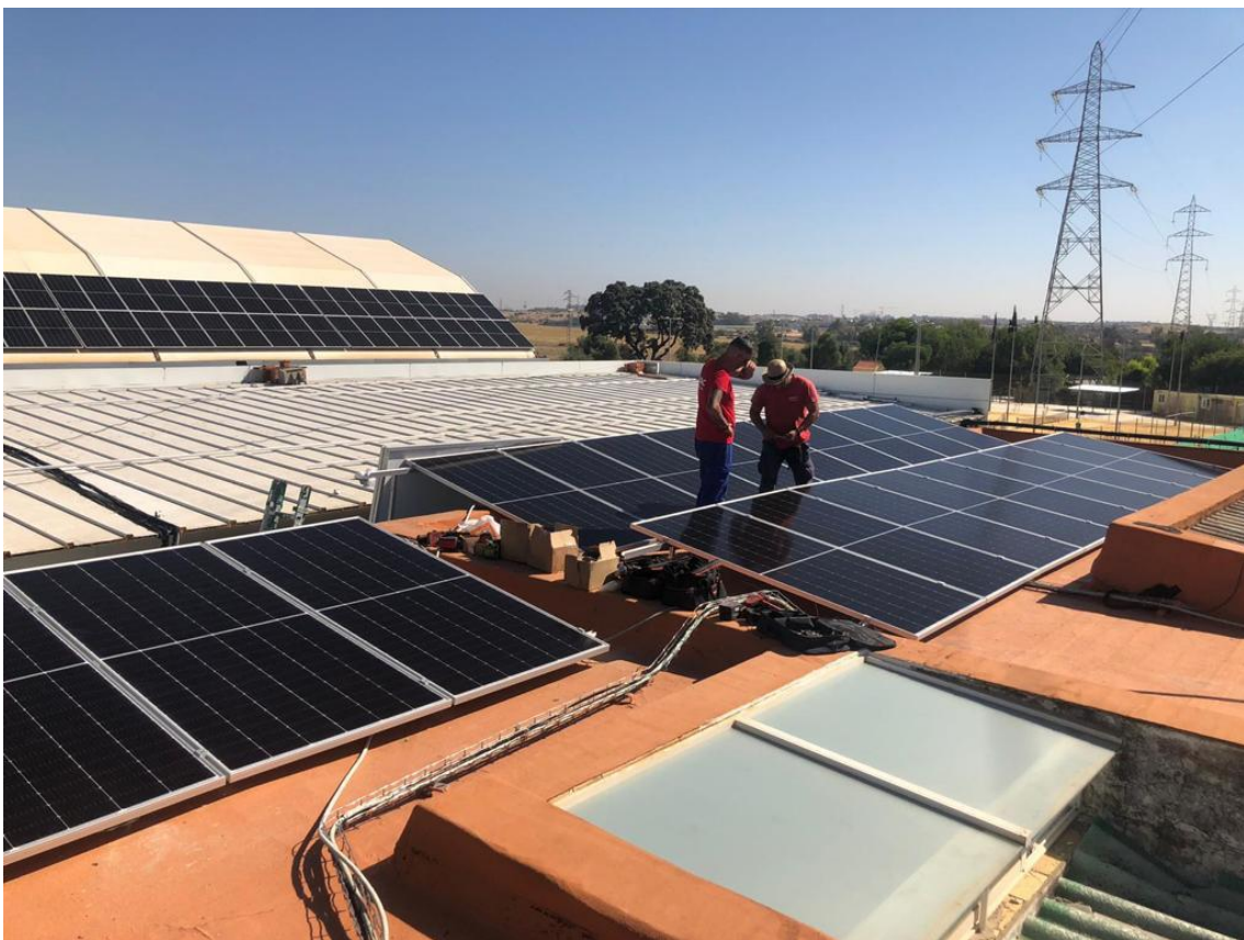
Ilustración 19. Proceso de instalación de paneles fotovoltaicos 4.
