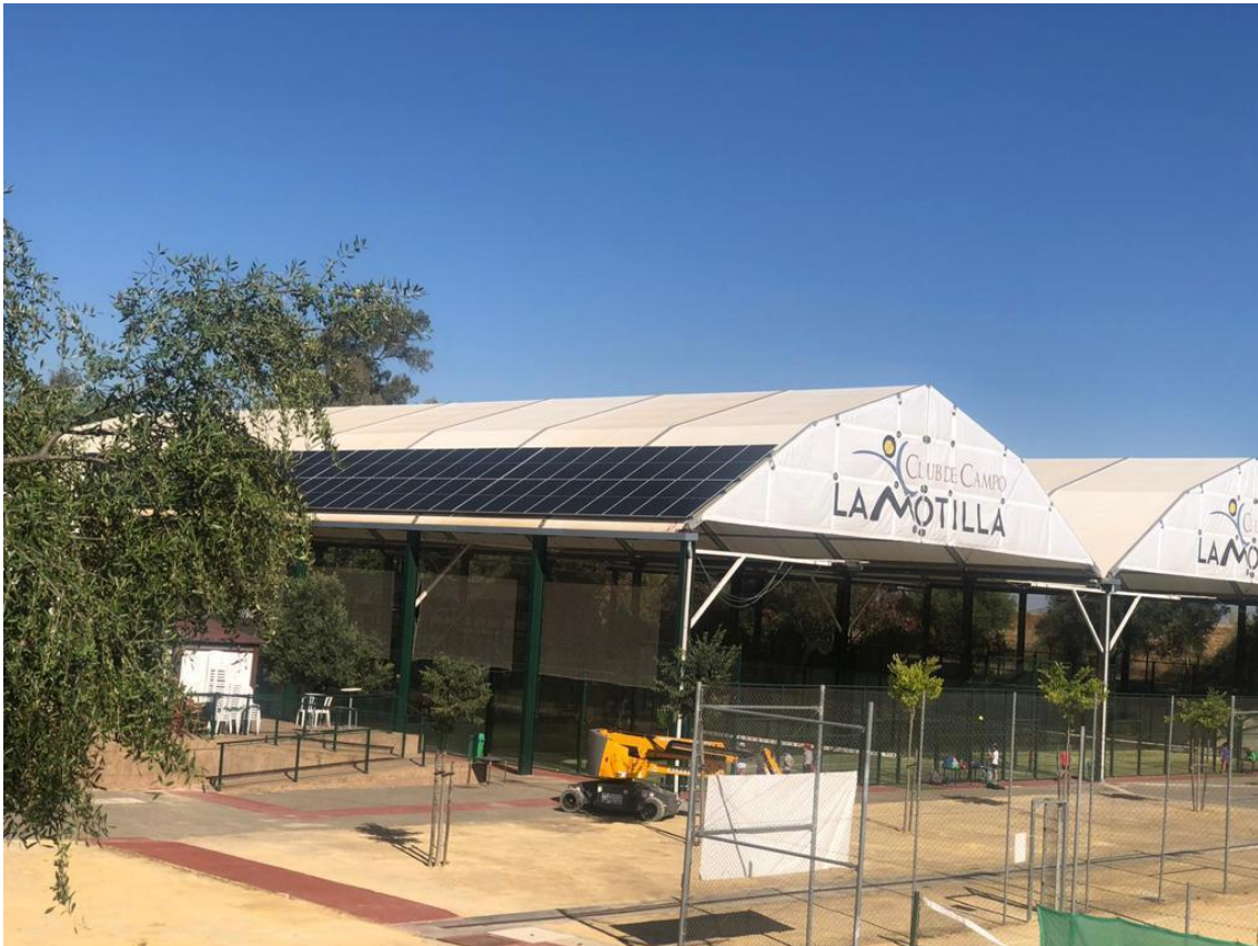
Ilustración 18. Proceso de instalación de paneles fotovoltaicos 3.
