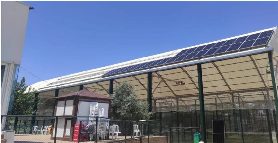
Ilustración 17. Proceso de instalación de paneles fotovoltaicos 2.
