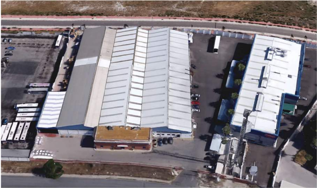
Figura 18: Vista de la cubierta de la nave.
