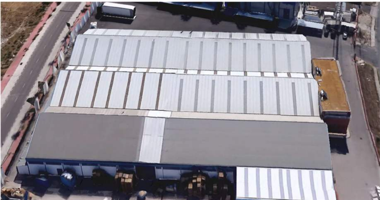
Figura 19: Vista de la nave desde el perfil oeste.
