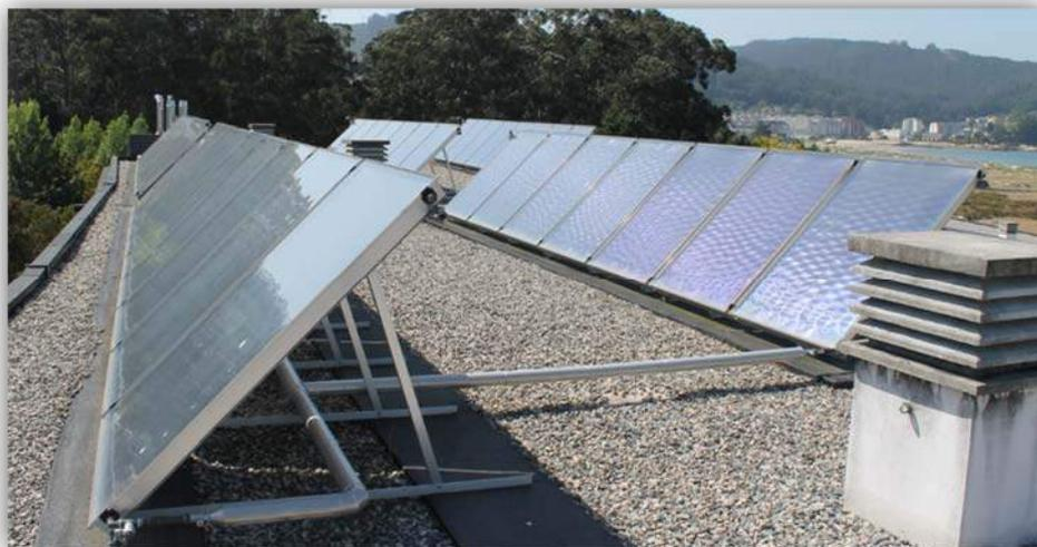
*Ilustración 73: Detalle de paneles solares térmicos en cubierta. Edificio en Viveiro
