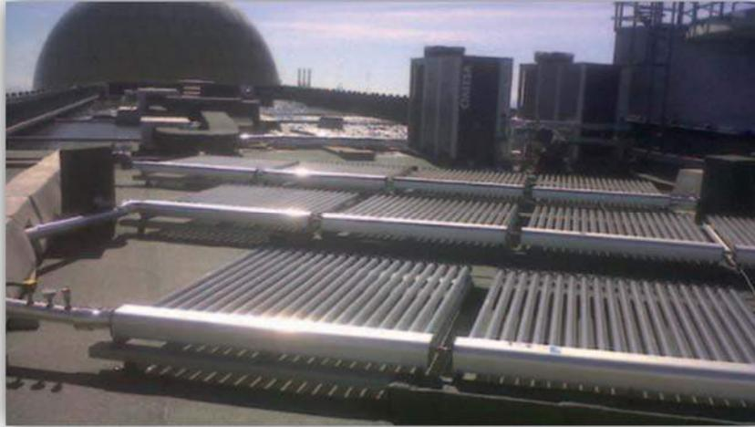
*Ilustración 19: Campo colectores térmicos de tubos de vacío.
