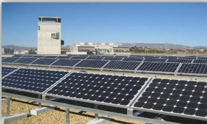
*Ilustración 21: Instalación fotovoltaica 48,4 kW.
