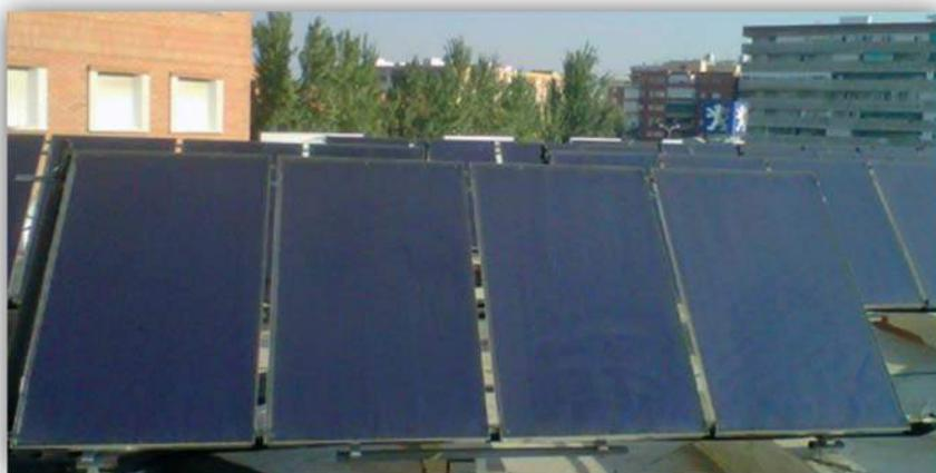
Ilustración 18: Campo colectores térmicos planos sobre cubierta plana.
