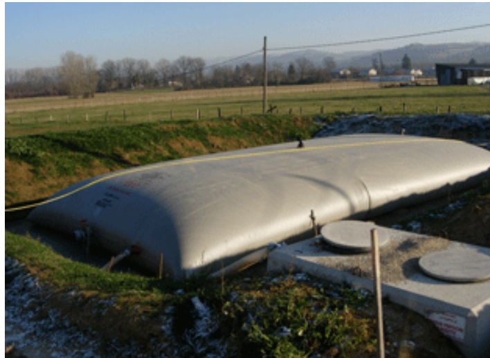
Figura 18. Cobertura de una balsa de almacenamiento de purines
