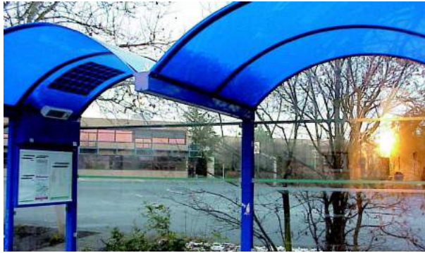
Parada de bus con paneles doblados de vidrio acrílico
